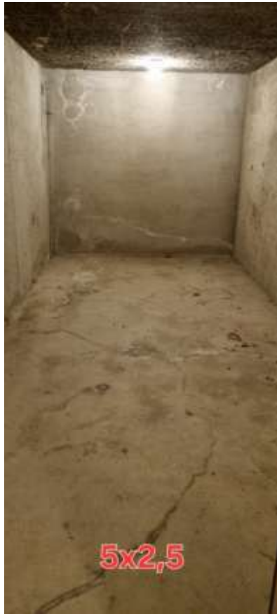
1) Lagerrom i kjeller
